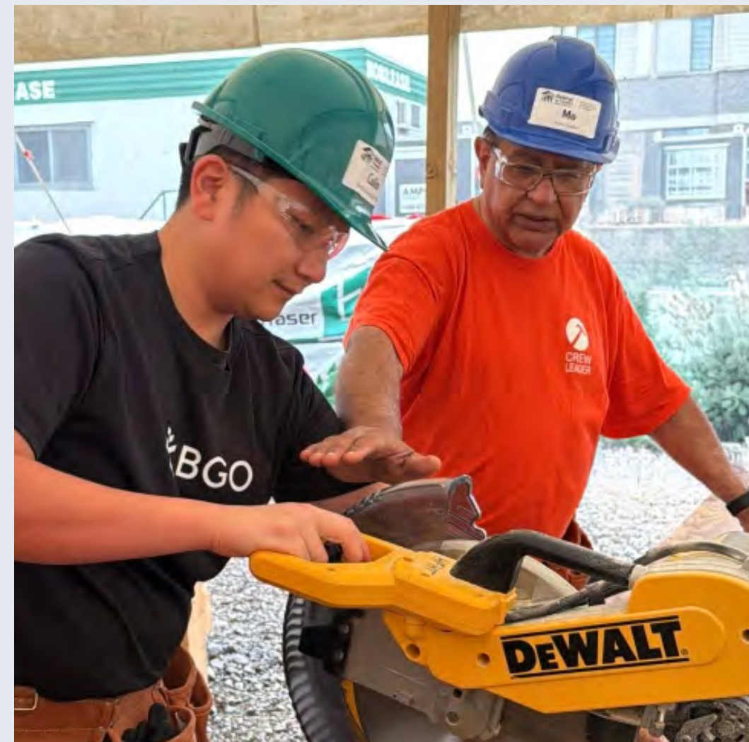
Journée de construction avec Habitat pour l'humanité à Brampton, Ontario, Canada
